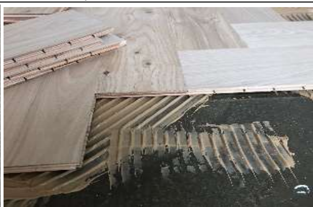
#2 Rechtstreekse verlijming met de L34 lijmen
