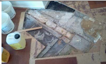
Prepareren en schoon maken
