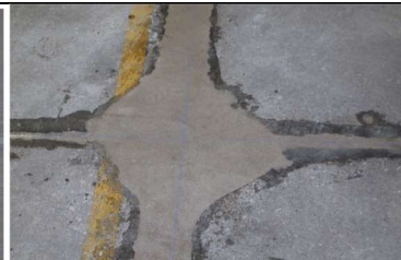
Opvullen met EP21 mortel
